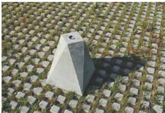
Tot een halve cm onder het niveau van de stenen wordt de grasgridtegel gevuld met grond. Zo gedijt het gras beter omdat het niet direct in contact komt met auto's.
